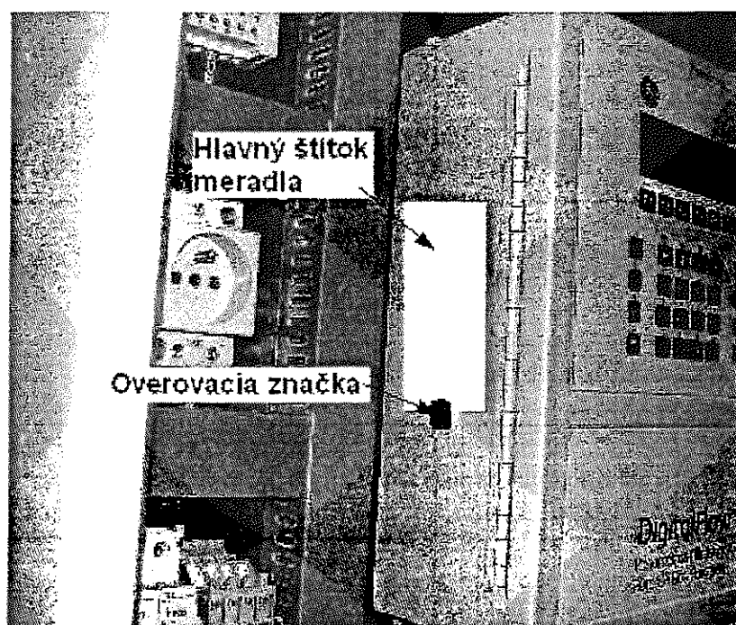
Obr. č. 7 Umiestnenie overovacej značky
