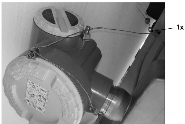
obr.3 Zabezpečenie krytov prevodníka, prepojenia so senzorom a konštrukciou stojana
