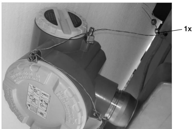
Obr. 5 Zabezpečenie snímača prietoku CNGmass výrobcu Endress+Hauser Flowtek AG, zabezpečenie krytov prevodníka, prepojenia so senzorom a konštrukciou stojana.
